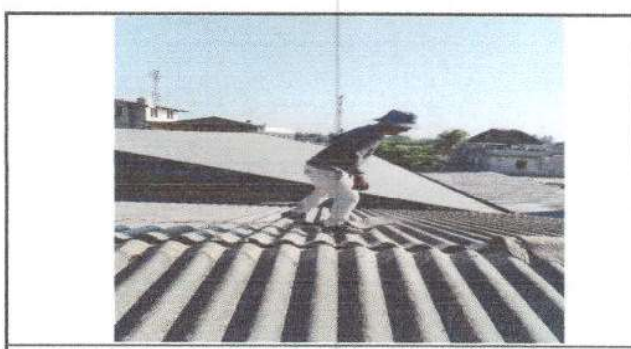
Foto 6: sustitución de duralita por lamina troquelada calibre 26 y mantenimiento de soporte de metal
