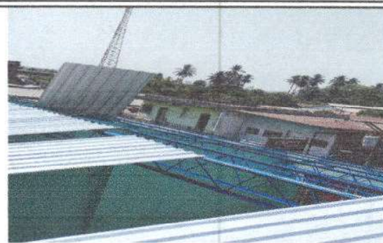
Foto 2: sustitución de duralita por lamina troquelada calibre 26 y mantenimiento de soporte de metal
